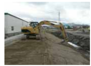
ミニグラウンド周辺の土工事の様子
