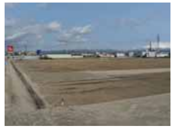
病院棟建設地の土工事の様子
