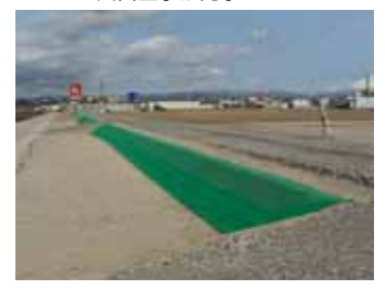
法面工事が完了しました
