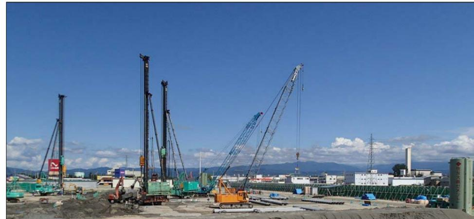
建物の基礎部分に、地震による倒壊を防止するため、太さ60cmと90cmの基礎杭(電柱のようなもの)を南棟195本 北棟76本 計271本を地下40mの深さまで打ち込みました。
