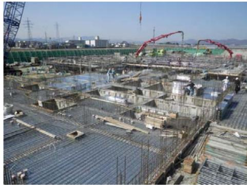
1階の床の鉄筋・型枠の組み立て工事をおこなっております。
