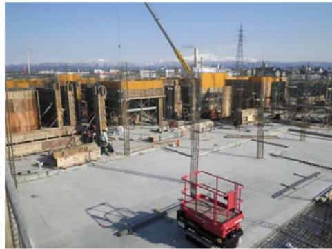
1階の壁の鉄筋・型枠の組み立て工事を行っております。
