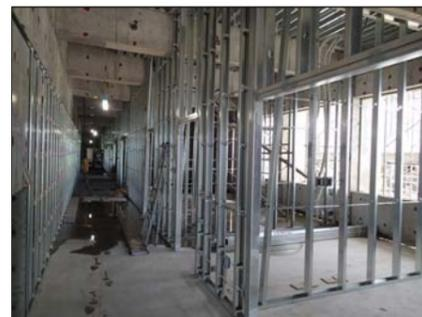
1階の間仕切り壁の組み立て工事を行っています。
