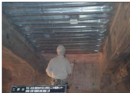
1階の床下の断熱材の吹き付けの工事をおこなっています。
