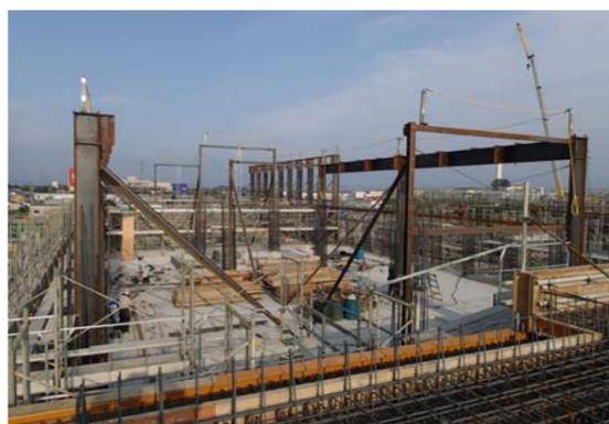
2階の鉄骨の組み立て工事を行っています。
