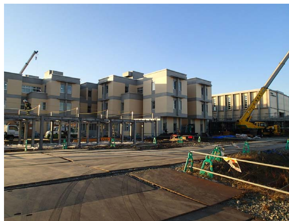
南棟・東側から撮影
