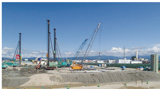
基礎杭打設工事 8月上旬工事完了
