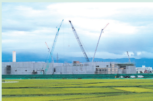
国道7号三川バイパスからの遠景
